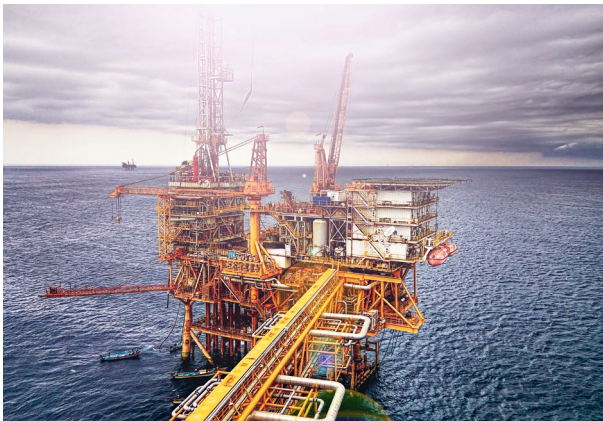
Offshore-Plattform: Der VCI sprach sich unter anderem gegen ein übereiltes Gasembargo aus.
