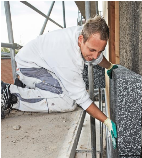
© Ingo Bartussek / Fotolia. Mit Dämmmaterialien aus Polystyrol oder Polyurethan lässt sich der Bedarf an Heizenergie auf weniger als ein Drittel reduzieren.
