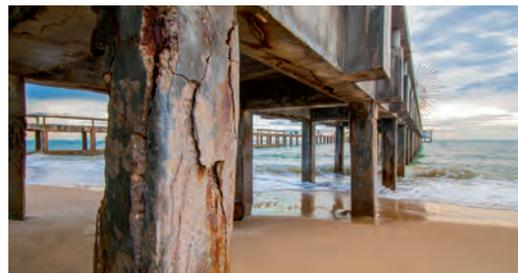
Abb.2: Stahlkorrosion durch Chloridionen
