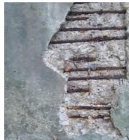
Abb. 2: Stahlkorrosion infolge der Karbonatisierung
