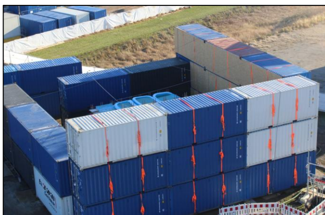
Abbildung 10: Schutzzeinhäusung mit Container und Wasserdach/-wände (© Foto Shell)
