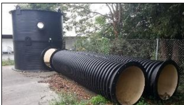
Abbildung 7: Schutzkonstruktion (Ramses) mit Zugangsrohr (© Foto BASF SE)
