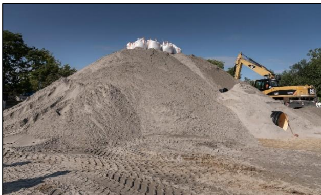
Abbildung 5: pyramidenförmige Schutzkonstruktion (Ramses) mit Zugangsrohr in der Bauphase (© Foto BASF SE)
